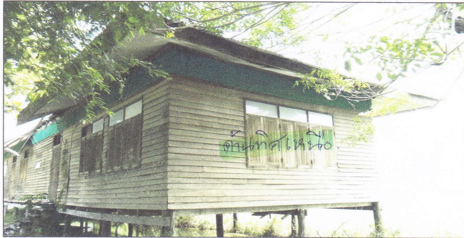
ภาพอาคารอเนกประสงค์ ขึ้นทะเบียนเลขที่ พบ-472 หลังลำดับที่ 2 ด้านทิศเหนือ
